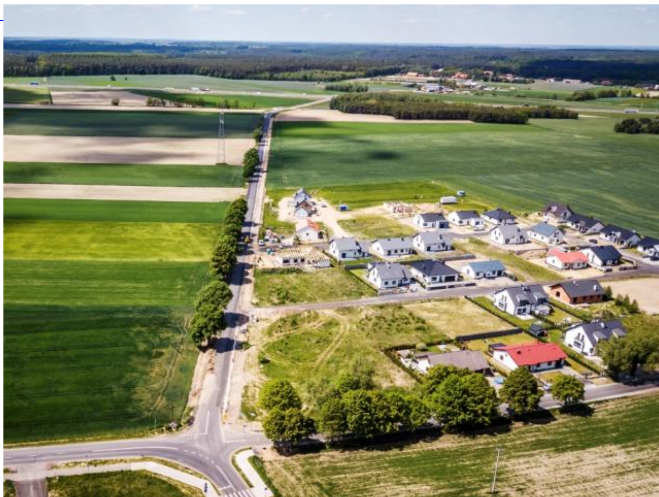
Przebudowa drogi Lipno - Smyczyna
