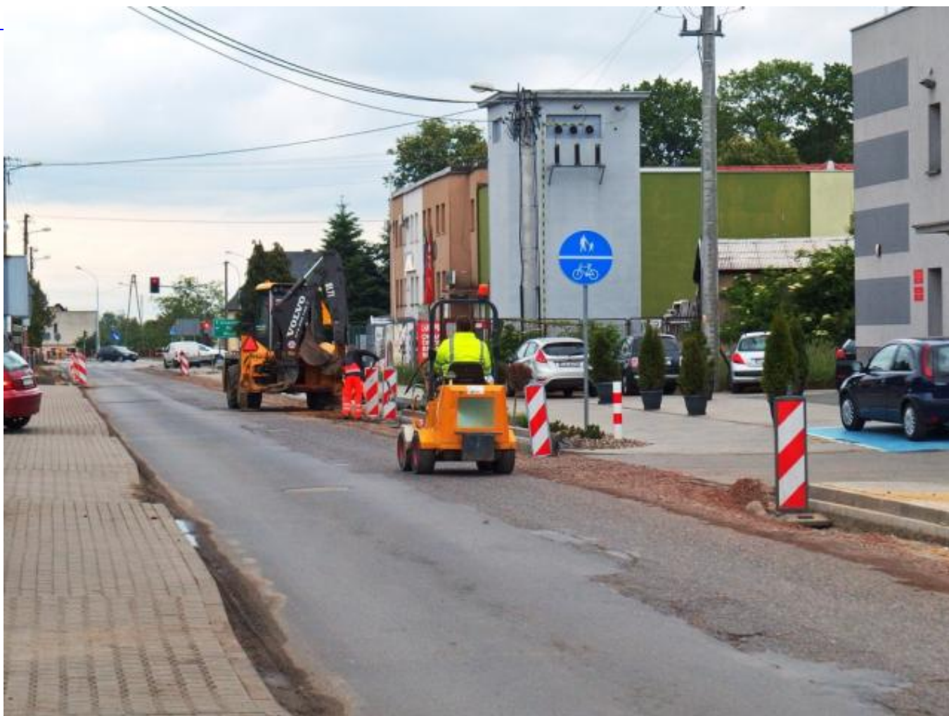
Przebudowa drogi Lipno - Smyczyna
