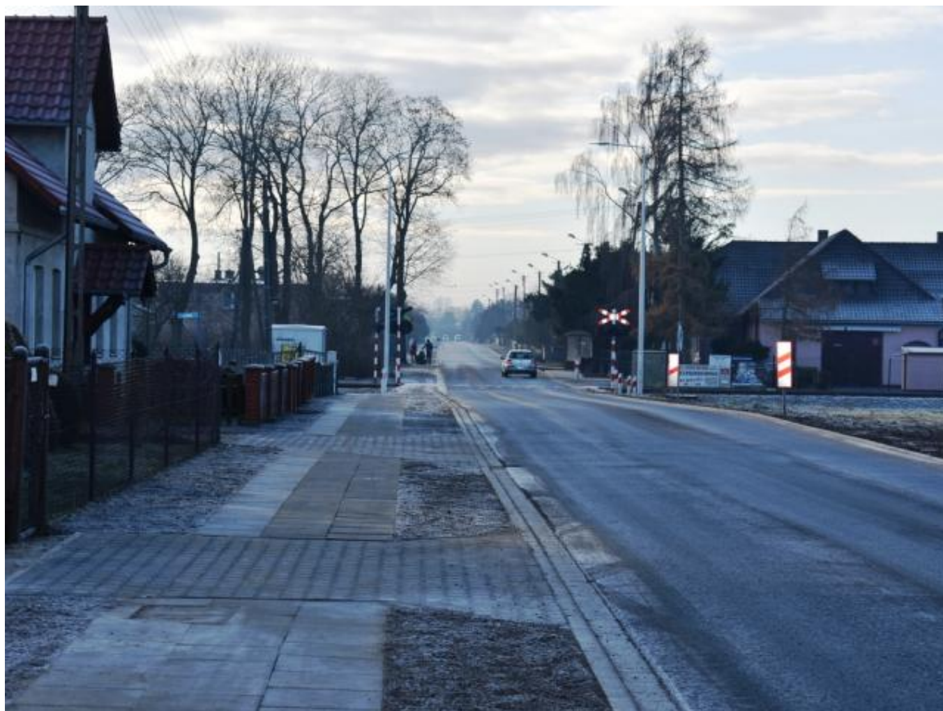
Przebudowa drogi w Krzycku Wielkim
