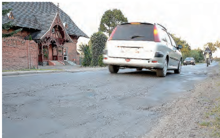
Jedną z głównych inwestycji realizowanych w 2017 roku w powiecie leszczyńskim ma być modernizacja ul. Dworcowej i Święciechowskiej w Wilkowicach.
