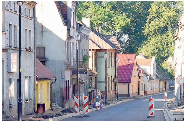
▲ Na ul. Leszczyńskiej nie ma już szpecących słupów energetycznych, gdyż nowa instalacja ułożona została pod ziemią. Przebudowana ulica będzie bezpieczniejsza dla kierowców, pieszych i rowerzystów.
