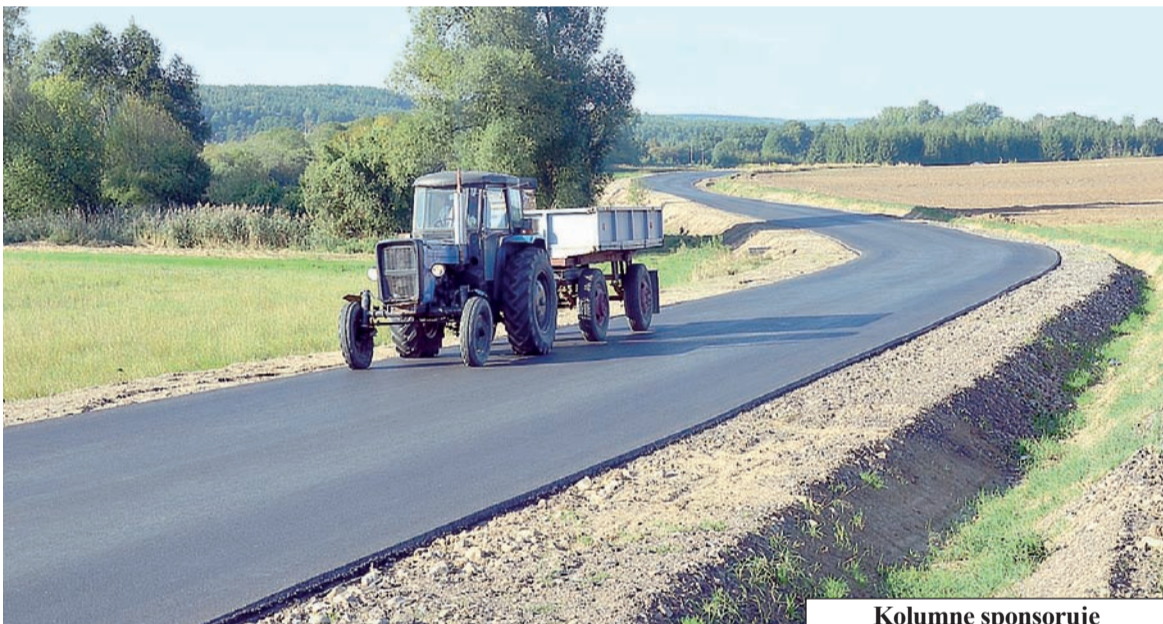
▲ Na odcinku od osieckiego Letniska do Berdychowa ułożono już warstwę wyrównującą i ścieralną asfaltu. Droga jest już prawie gotowa.
