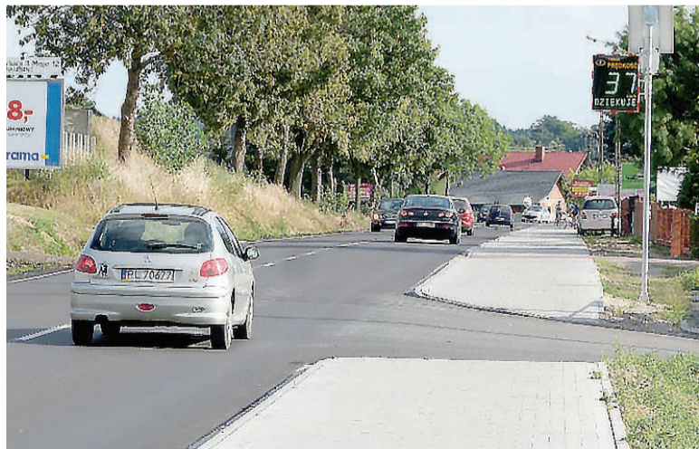
▲ Zmodernizowane w bieżącej kadencji drogi powiatowe poprawiają nie tylko komfort jazdy, ale również stały się bezpieczniejsze. Wiele odcinków ma w pasie drogowym ścieżki rowerowe. Nowy standard zawitał między innymi na obciążonej dużym ruchem drodze Włoszakowice-Boszkowo-Letnisko. Inwestycja zrealizowana w bardzo krótkim czasie kosztowała około 4,6 mln złotych, z czego połowę stanowiło dofinansowanie z „Programu rozwoju gminnej i powiatowej infrastruktury drogowej na lata 2016-2019”. Około 290 tys. zł przekazała też gmina Włoszakowice.
