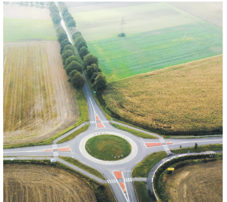
▲ W ramach przebudowy drogi powiatowej Osieczna – Łoniewo – Kąkolewo powstało największe w powiecie rondo, które poprawiło bezpieczeństwo i płynność ruchu na ważnym skrzyżowaniu. Od ronda do krajowej „12” zbudowana zostanie w tym roku ścieżka rowerowa, dzięki czemu rowerzyści zyskają długi trakt Oporowo – Pawłowice – Osieczna – Goniembyce.
