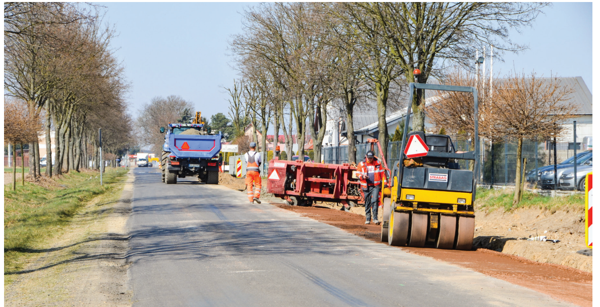
▲ Intensywne prace prowadzone są na modernizowanym 2,6-kilometrowym odcinku łączącym Wilkowice z drogą wojewódzką 309.
