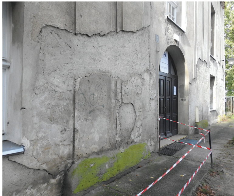
▲ Ochrona murów zamkowych oficyn przed wilgocią stała się jednym z remontowych priorytetów.
