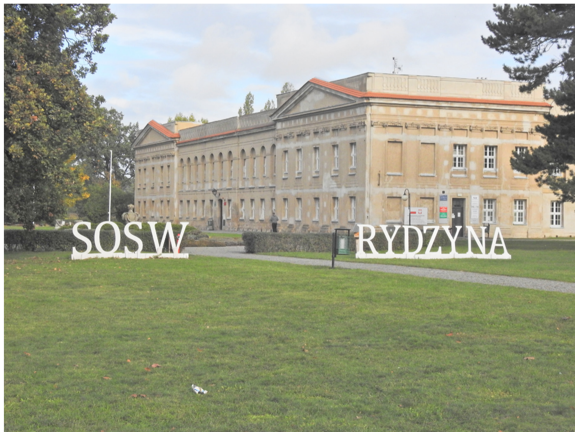
▲ Dachy na budynkach wchodzących w skład zachodnich oficyn będących siedzibą SOSW Rydzyna zostały już w całości zmodernizowane.
